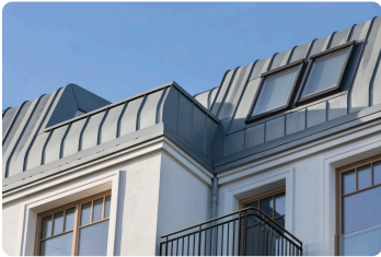
Caractéristiques constructives et matériaux / Type de toiture Charpente bois recouverte de zinc
