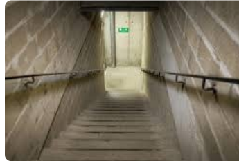
Accès - escalier, portes... /
