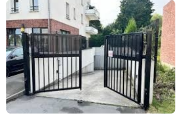
Accès - véhicules/piétons / Portail motorisé pour accès véhicules
