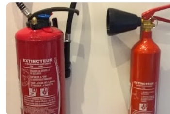
Travaux / Extincteur, local machine Sous-sols et paliers d'étages.
